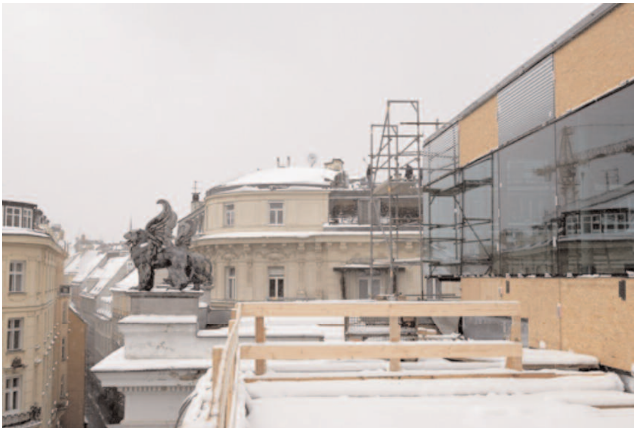
Ausblick: Die letzten Detailarbeiten auf dem Dach des Ronacher konnten bereits Ende November 2007 abgeschlossen werden
