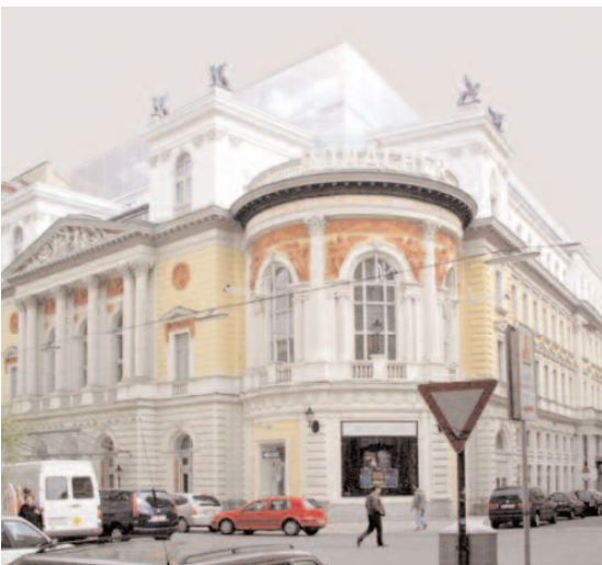
Die Zukunft: Das Ronacher nach der Funktionssanierung
