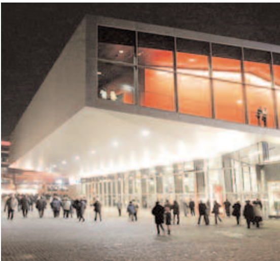
Die Wiener Stadthalle ist für das Jubiläumsjahr gerüstet
